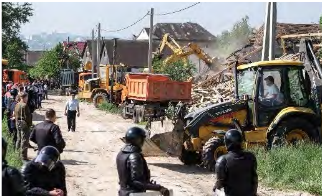
Рис. 2. Снос незаконных построек в Плеханово ( https://myslo.ru ).
